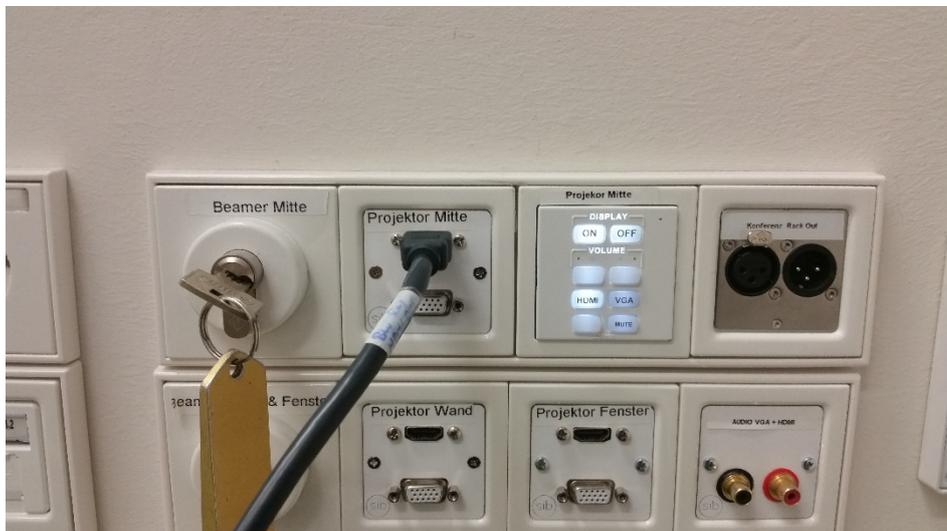
Verbinden Sie die Steuerung und den Laptop mit Hilfe des HDMI-Kabels. Schalten Sie anschließend den Beamer über den Schalter ON ein. Der Beamer sollte nach einer gewissen Startzeit (15 – 20 Sekunden) automatisch den angeschlossenen Laptop als Quelle gefunden haben. Sollte kein Bild zu sehen sein, prüfen Sie bitte, ob der Schalter HDMI aktiviert ist (ggf. einschalten).
