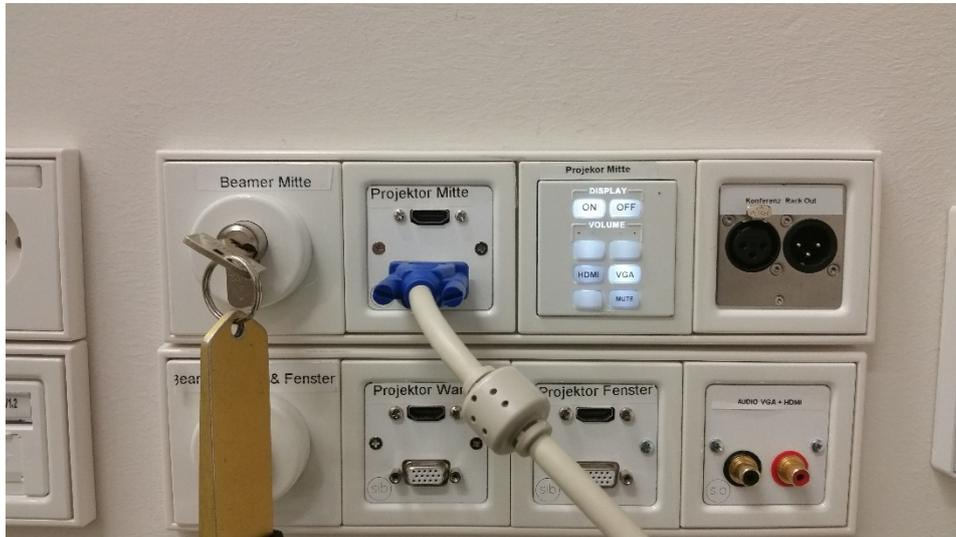
Verbinden Sie die Steuerung und den Laptop mit Hilfe des VGA-Kabels. Schalten Sie anschließend den Beamer über den Schalter ON ein. Der Beamer sollte nach einer gewissen Startzeit (15 – 20 Sekunden) automatisch den angeschlossenen Laptop als Quelle gefunden haben. Sollte kein Bild zu sehen sein, prüfen Sie bitte, ob der Schalter VGA aktiviert ist (ggf. einschalten).
