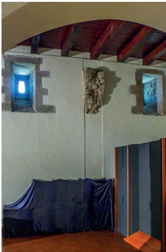
Abb. 12. Lagopesole, domus, Ablaufbecken zur Handreinigung und Latrine im Inneren des großen Turms (Foto: Klaus Tragbar).
